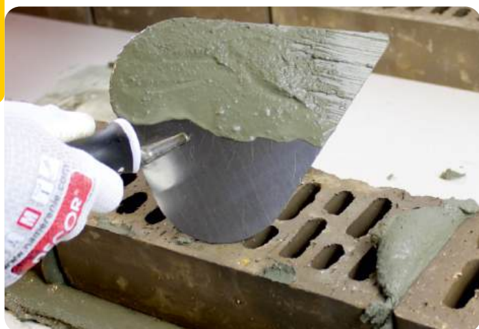
Для укладки кирпича
