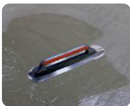
Для нанесения декоративного бетона
