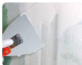
Мелкая сетка 3x3 мм обеспечивает более надежное укрепление поверхности
